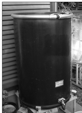
雨水貯留施設
