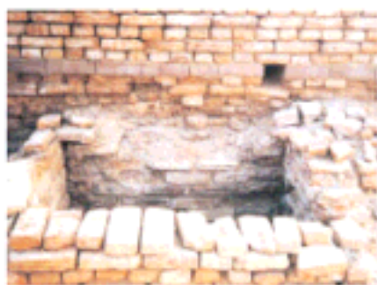
(写真:2) もヘンジョ・ダロの家々から流された下水をこの「マス」に受け入れ、地中にしみこませていました。
