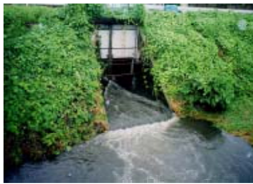
・大雨時における雨水吐口からの越流水
