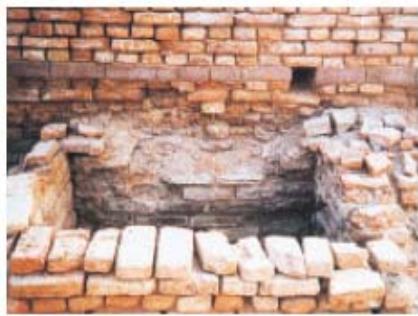
(写真：2) モヘンジョ・ダロの家々から流された下水をこの「マス」に受け入れ、地中にしみこませていました。
