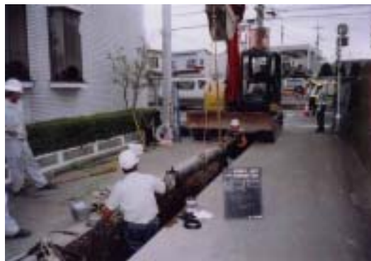
（配水管の整備工事状況）
