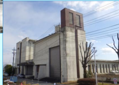
沈砂池ポンプ棟
