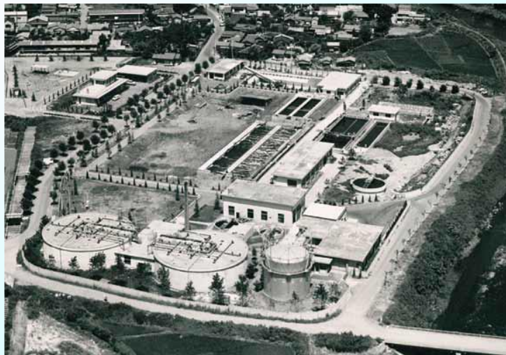
旧 田川下水処理場（昭和42年）
