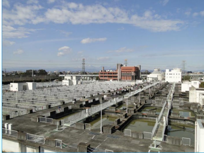
現在の川田水再生センター
