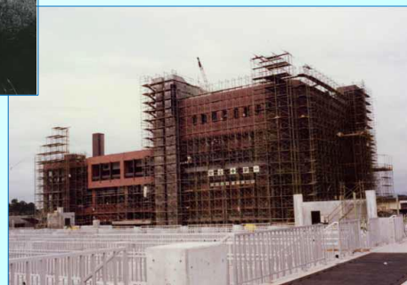
管理棟タイル貼工事
