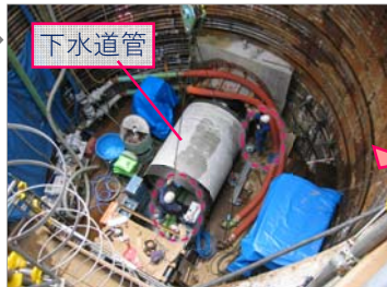
下水道管埋設工事
