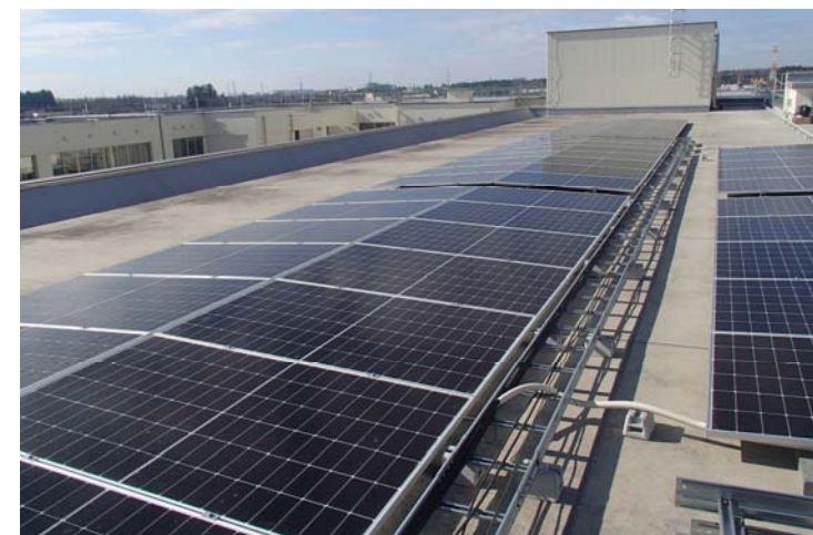
ゆいの杜小学校屋上に設置した太陽光発電設備
