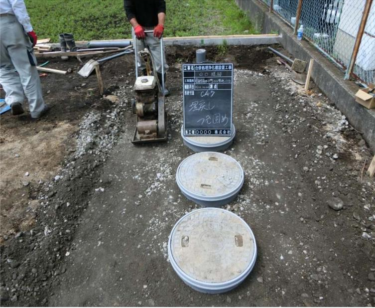
埋戻し後，転圧している状況を，転圧機が写り込むように撮影すること。
