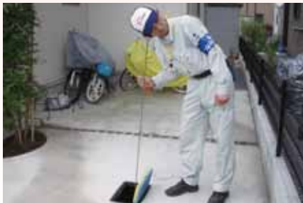
〈宅地内でのメーターで調査中〉
