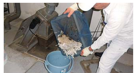
処理施設に流入した異物の除去作業
