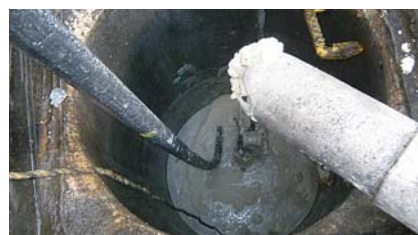
下水道管の清掃の様子
