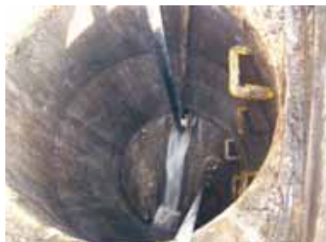
下水道管の清掃の様子
