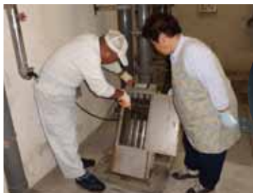
処理施設に流入した異物を取り除く 板戸地区農業集落排水施設管理組合の方々
