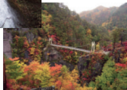
瀬戸合峡 渡らっしゃい吊橋
