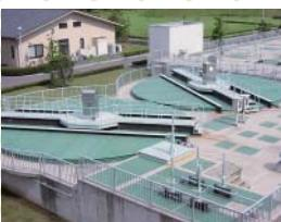
2～3時間ほど静かに下水を流して汚泥を沈め、表面の軽いゴミも取り除きます。
