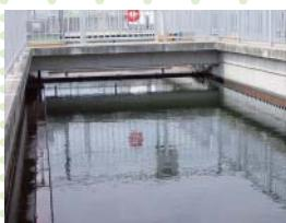
反応タンクで沈みやすくなった汚泥がここで沈められます。
