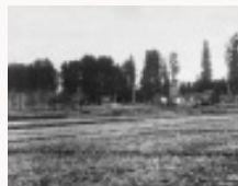
▲工事着手当時の今市浄水場
