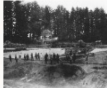
▲沈んでん池築造工事中の今市浄水場
