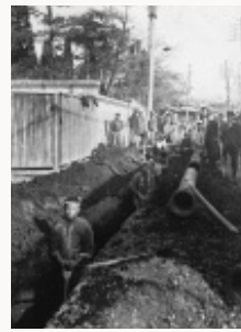
▲配水管敷設工事 宇都宮市内への配水管敷設工事は、大正3年(1914)、配水池(近し清住町桂林寺前、八幡町入口付近)から始まり、大正5年(1916)9月に全市内への配管を完了しました。
