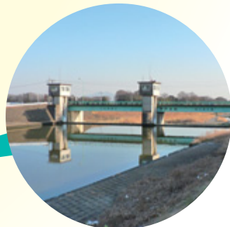
田川放水路の水門
