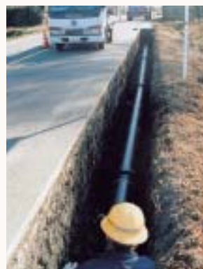
▲第六期拡張事業（配水管敷設工事）市民皆水道の実現、災害に強い水道施設づくり、安全性の向上を目的として第6期拡張事業に着手しました。
