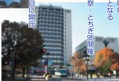
▲新市庁舎 地上16階の新市庁舎を旭1丁目に建設しました。
