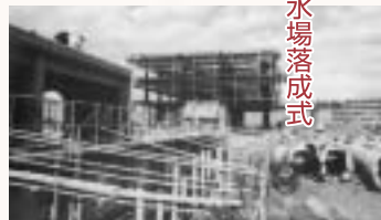
▲第四期拡張事業（建設中の松田新田浄水場）昭和44年、市街地の開発、産業の活性化により水需要の伸びが著しくなったため、建設省（現在の国土交通省）施工の川治ダムに水利権を求めました。
