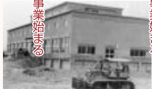
▲第三期拡張事業（白沢水源ポンプ室兼事務所棟の建設）昭和40年には下水道整備が本格的に開始され、給水需要は著しい伸びを示しました。このため、新しい水源として河内町白沢地内の地下水源を開発しました。
