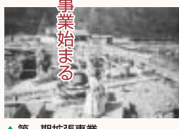
▲第一期拡張事業（工事中の山本浄水場）戦後、市勢は急速に膨張発展し、人口が22万人を突破しました。これら水需要の伸びに対応するため河内町宝井水源を開発し、第一期水道拡張事業を開始しました。
