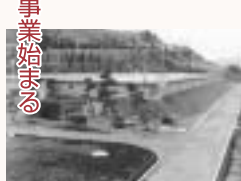
▲第二期拡張事業（山本浄水場配水池）市勢の発展に伴う人口の増加等により、第一期完了後、引き続き宝井水源を水源とした第二期の拡張事業に着手しました。
