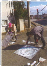
10月24日(土) ストップマーク補修作業
