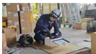
施工部 電気通信グループ Mさん (2023年入社)
