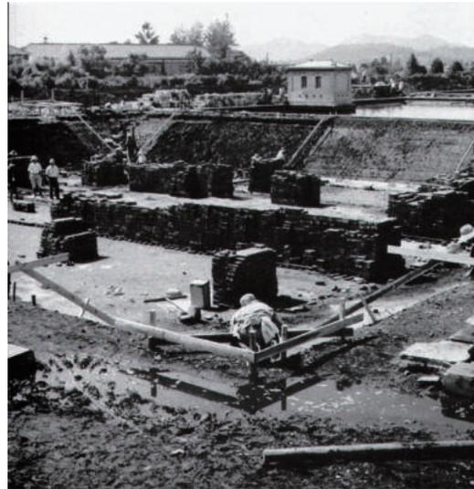
今市浄水場内沈殿池の復旧作業（昭和25年）
