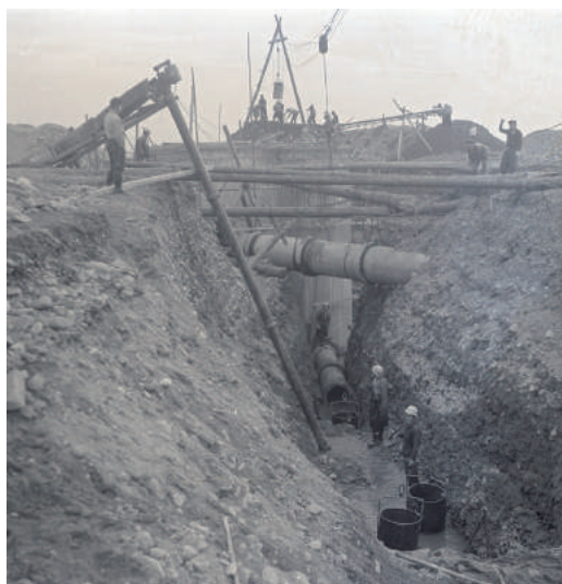
集水管工事(昭和34年1月)
