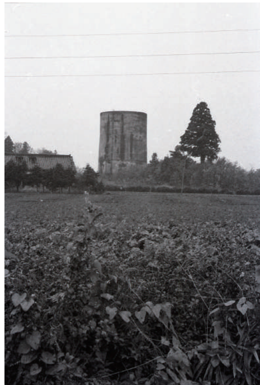
配水塔 (雀宮町簡易水道)
