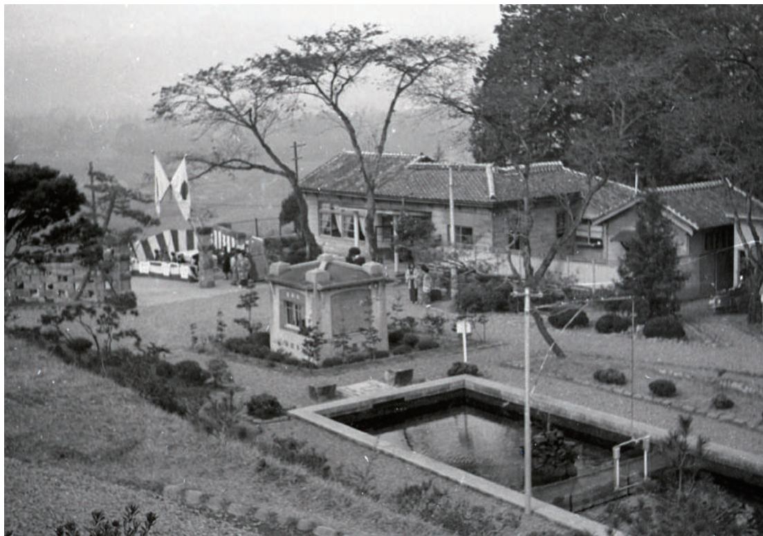
起工式の会場となった戸祭配水場（昭和30年11月）
