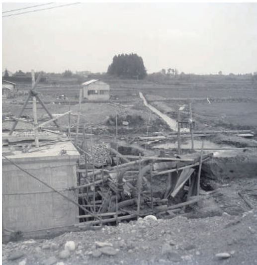
集水管工事 (昭和34年1月)
