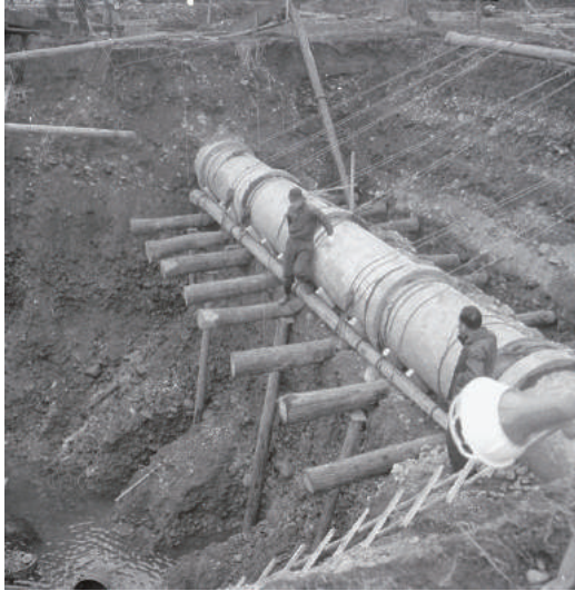
配水管布設工事
