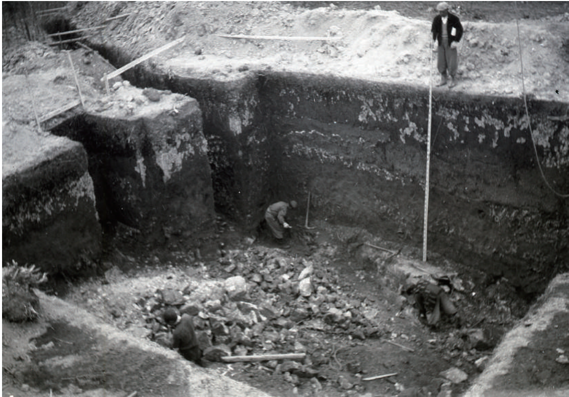
大谷簡易水道工事(昭和31年2月頃)
