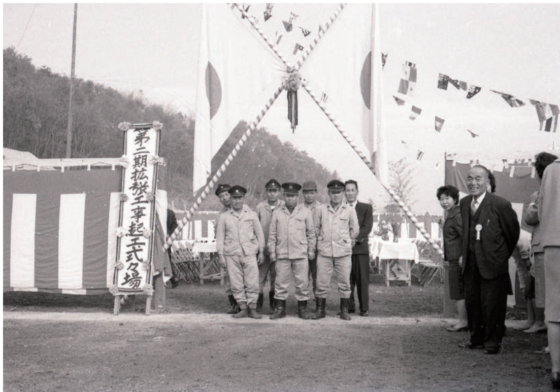
起工式の会場となった山本浄水場(昭和36年11月)
