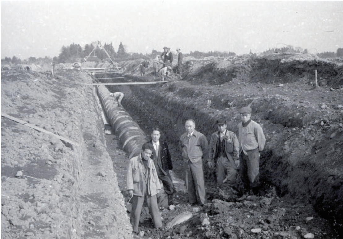
導水管布設 (昭和31年度)
