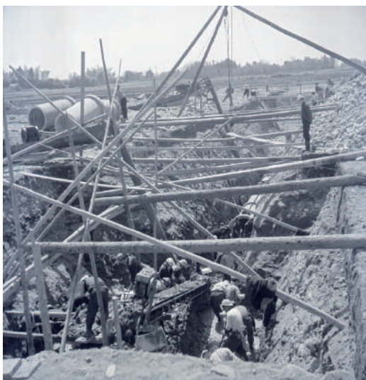
集水管を埋設(昭和33年)
