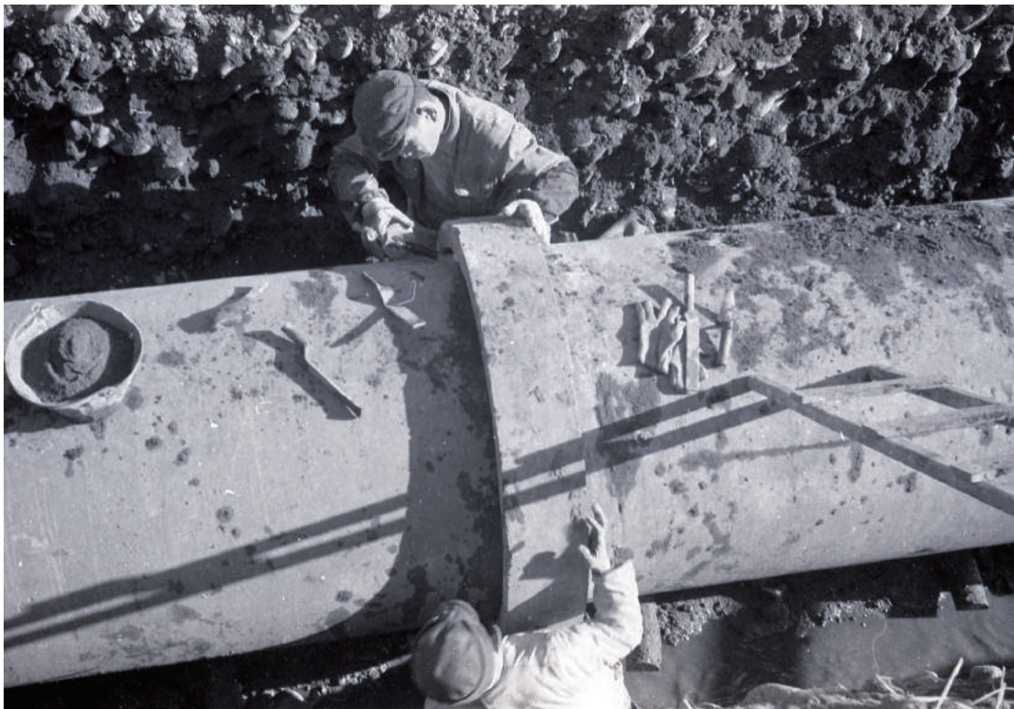
導水管をつなげる (昭和31年度)
