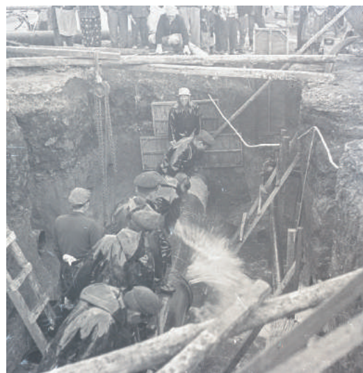
田原街道での本管接続工事(昭和33年)
