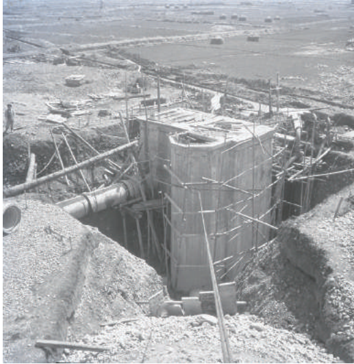
集水管工事 (昭和34年1月)
