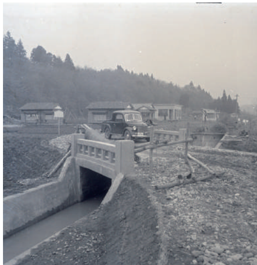
山本浄水場付近(昭和34年)
