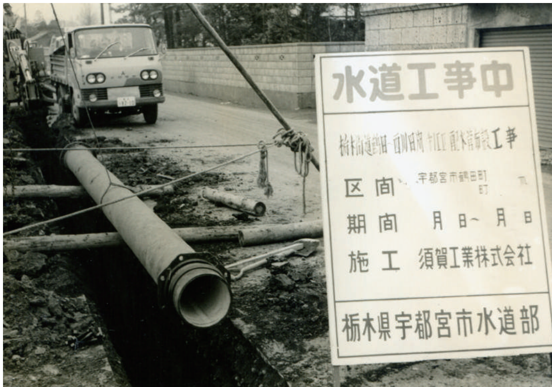
栃木街道（鶴田～西川田間）での配水管布設工事（昭和40年11月）
