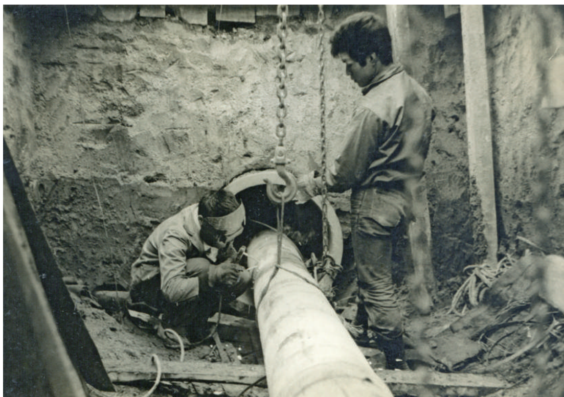
配水管溶接（昭和40年12月）
