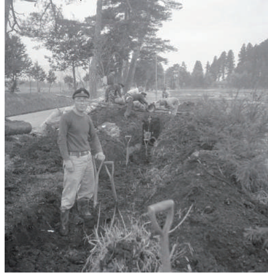
白沢街道での配水管布設工事（海道町付近）
