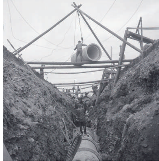
集水管を埋設(昭和33年)
