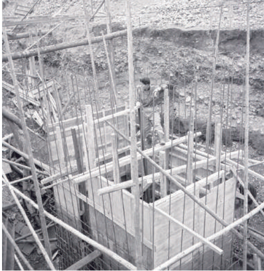
調整井を建造(昭和33年)
