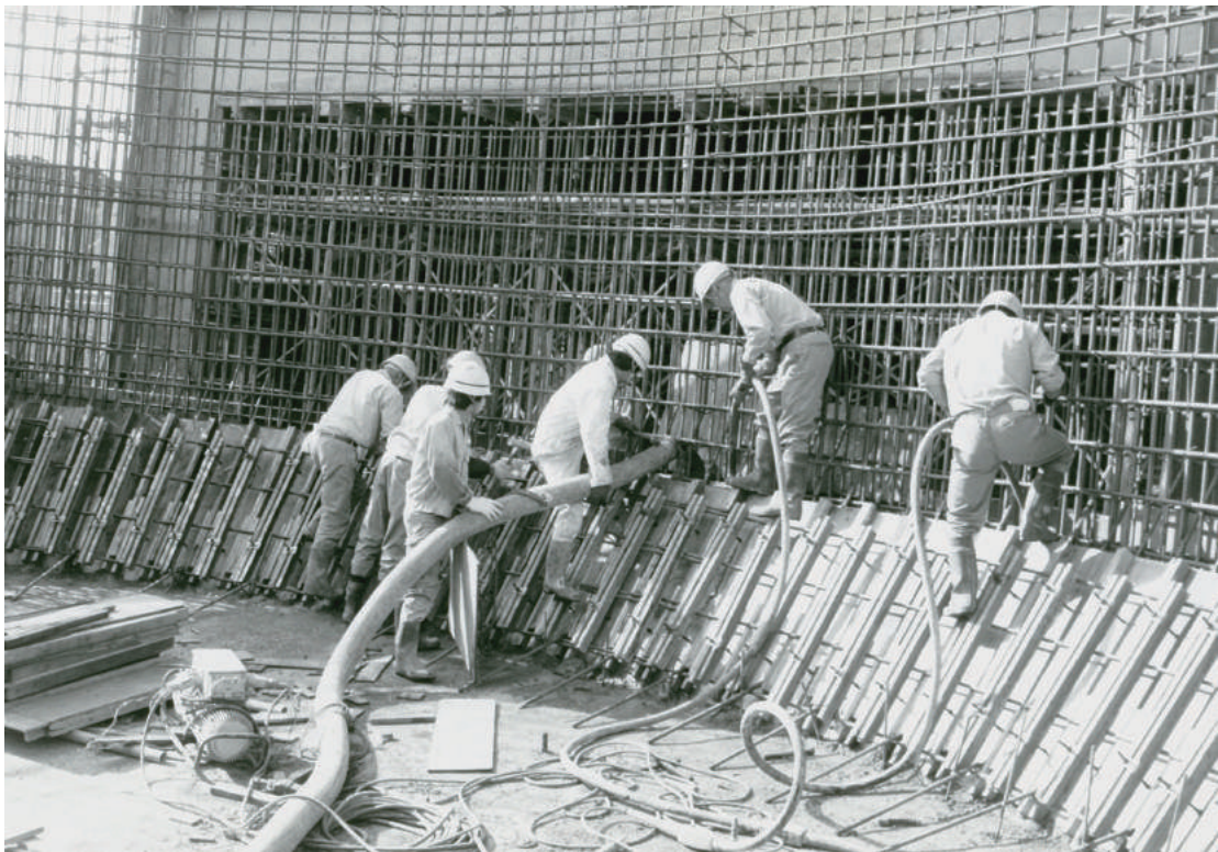
ハンチ・コンクリート打設
