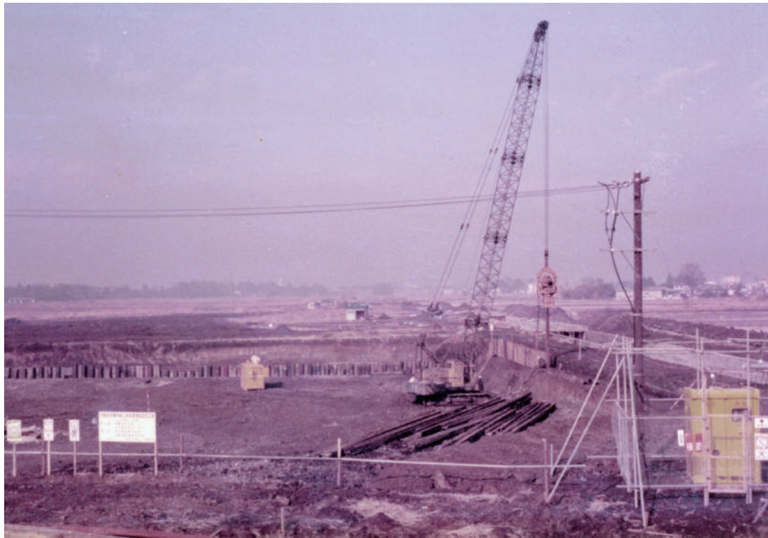
建設着工当時
