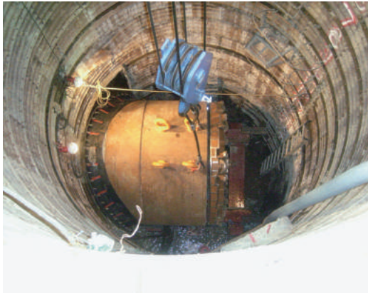
貯留施設工事(平成21年：不動前4丁目)
