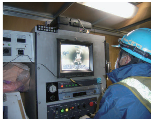
ライニング工法による老朽管渠改築更新工事(平成25年：大曾2丁目)
