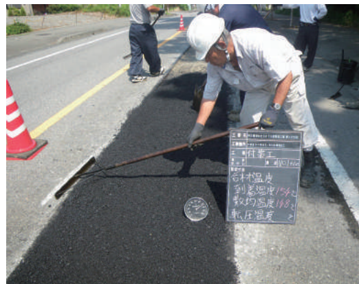
路面復旧(中岡本町)
