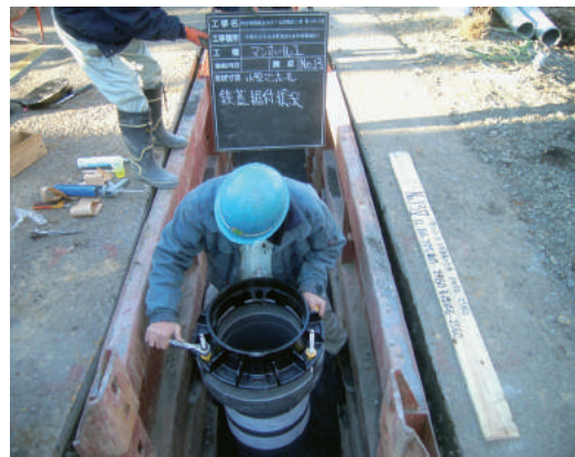
国本特環地区での小型マンホール設置工事(平成22年:宝木町)
