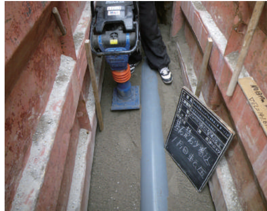
管布設(中岡本町)
