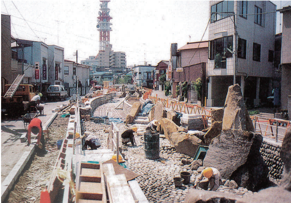
修景工事中の上段水路(昭和62年：剣橋付近)
