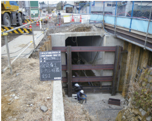
鶴田川5-1号幹線での雨水幹線工事(平成25年：鶴田町)
