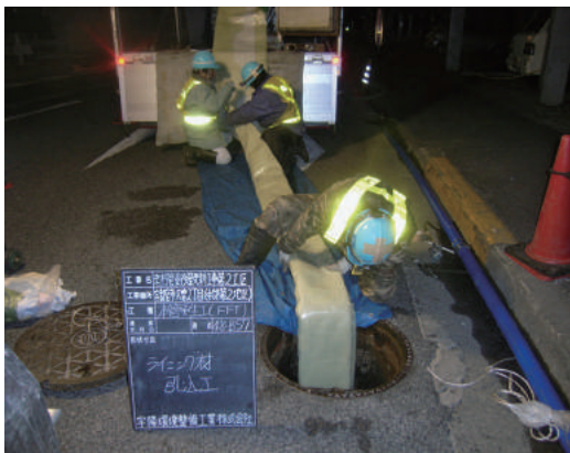
ライニング工法による老朽管渠改築更新工事(平成25年：大曾2丁目)
