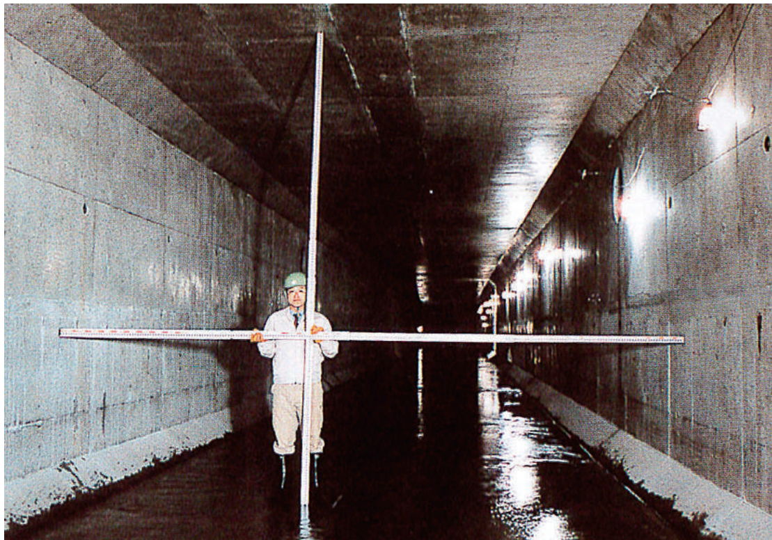
完成した二層構造下段水路（昭和62年）
