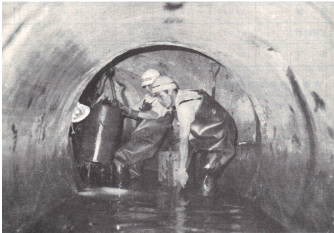
管渠内の汚泥清掃作業
