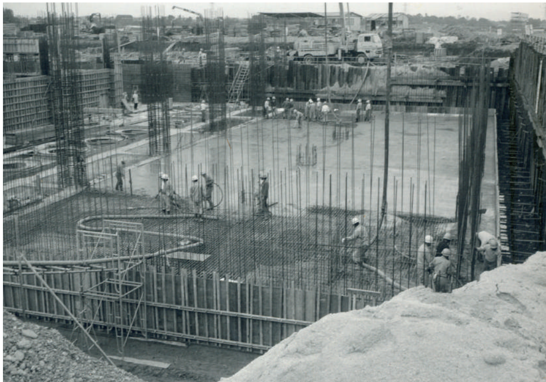
管理棟地下1階ベースコンクリート打設
