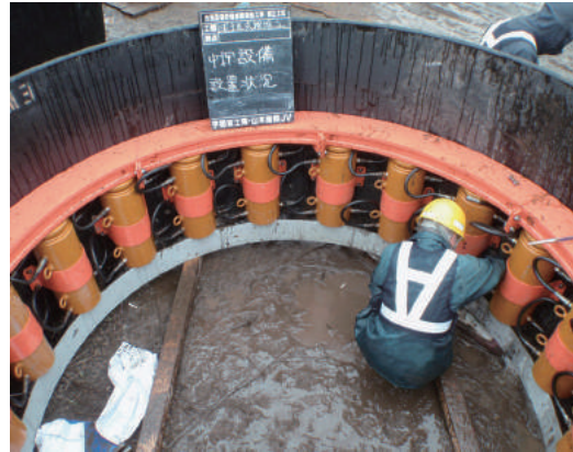
貯留施設工事(平成21年：不動前4丁目)
