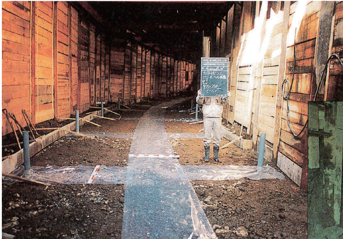
掘削作業が終了した二層構造下段工事（昭和62年）
