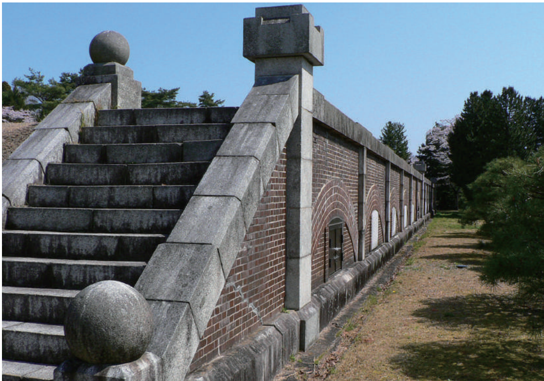
戸祭配水場 (中戸祭町)
