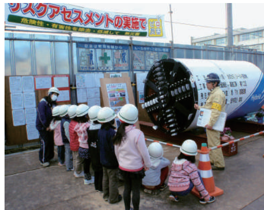
合流式下水道改善事業の工事現場を見学する市立東小学校の児童たち
