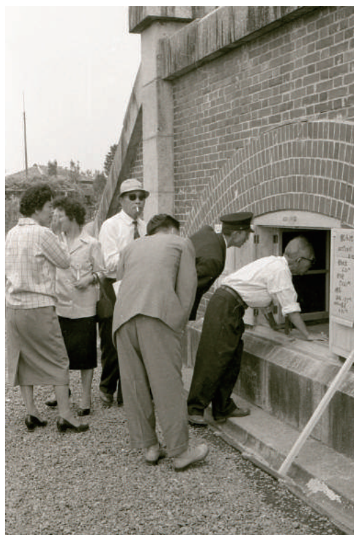
配水池内部をのぞく見学者たち
