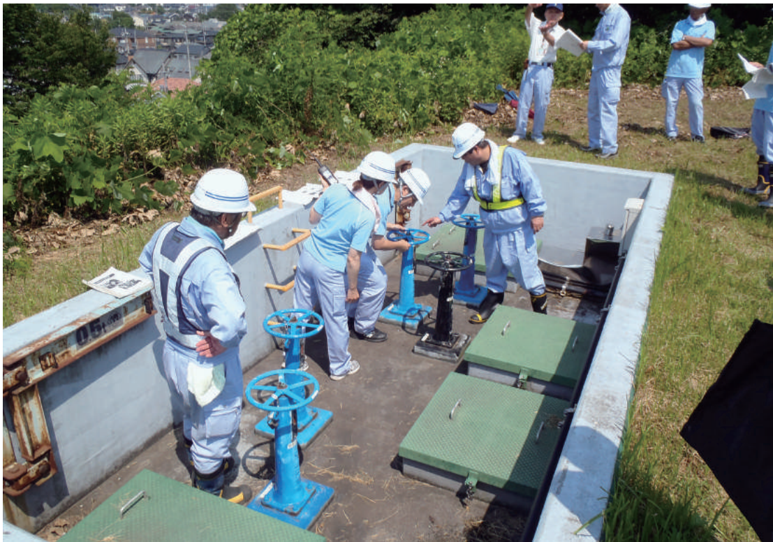
応急給水訓練 (戸祭配水場)
