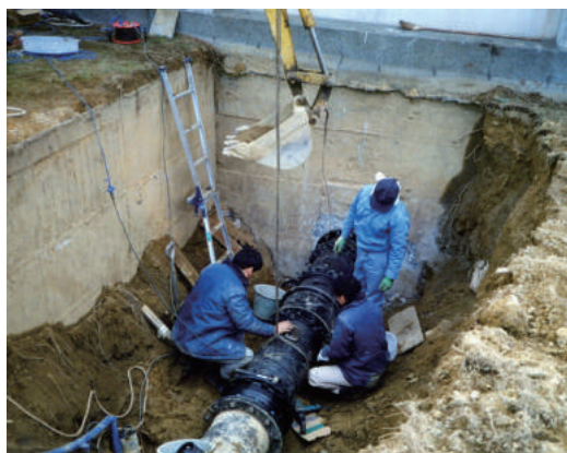
応急復旧作業（平成7年：兵庫県西宮市）
