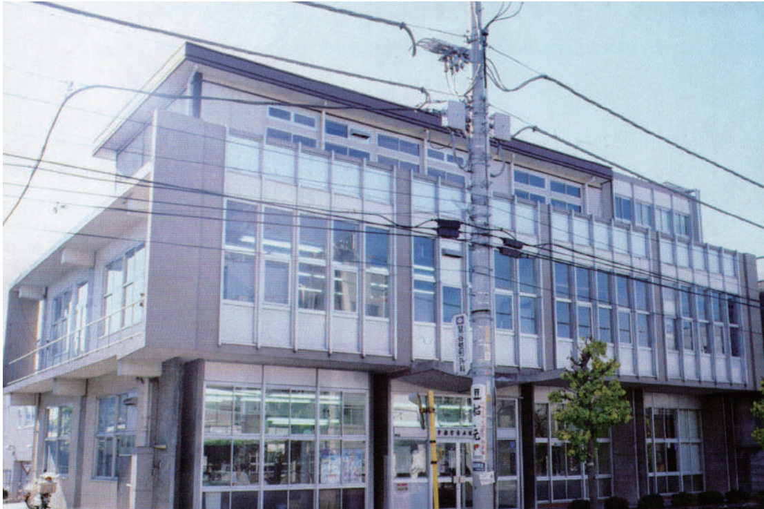
本町にあった宇都宮市水道局庁舎。昭和34(1959)年9月竣工(『うつのみやの水道 通水70周年記念誌』)
