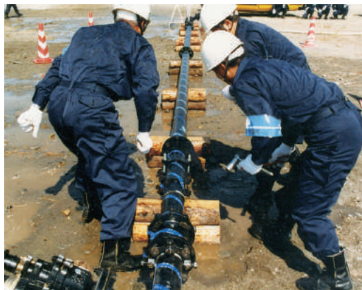
破裂・噴出状態を想定した訓練（昭和61年）
