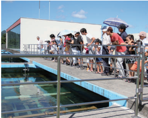
ろ過池を見学(松田新田浄水場)
