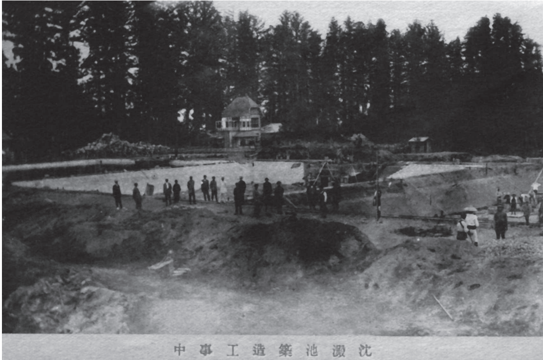
図1-17 今市浄水場沈澱池工事(『宇都宮市水道誌』)
