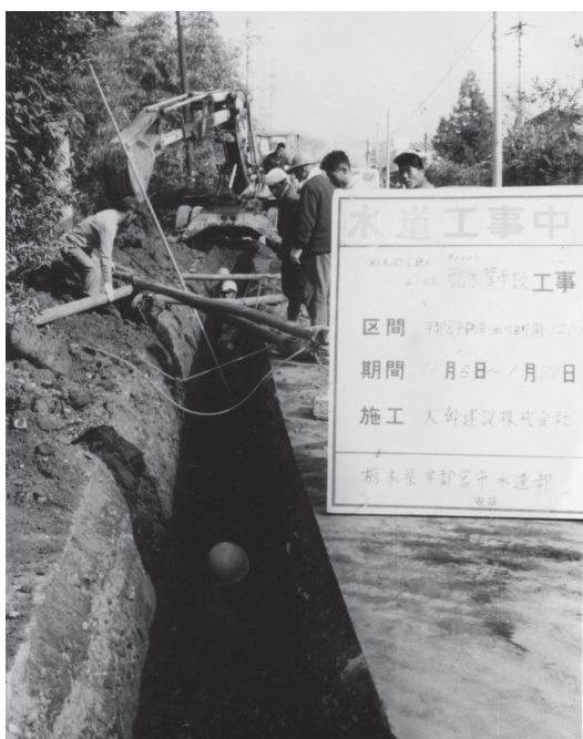
図5-3 県道宇都宮栃木線(栃木街道)での配水管 布設工事(昭和40年12月)
