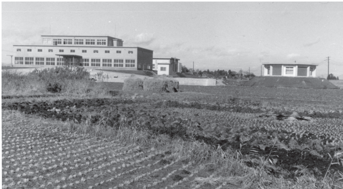
図5-12 白沢水源地ポンプ室兼事務所棟(左)と2号水源井(右：昭和44年2月)
