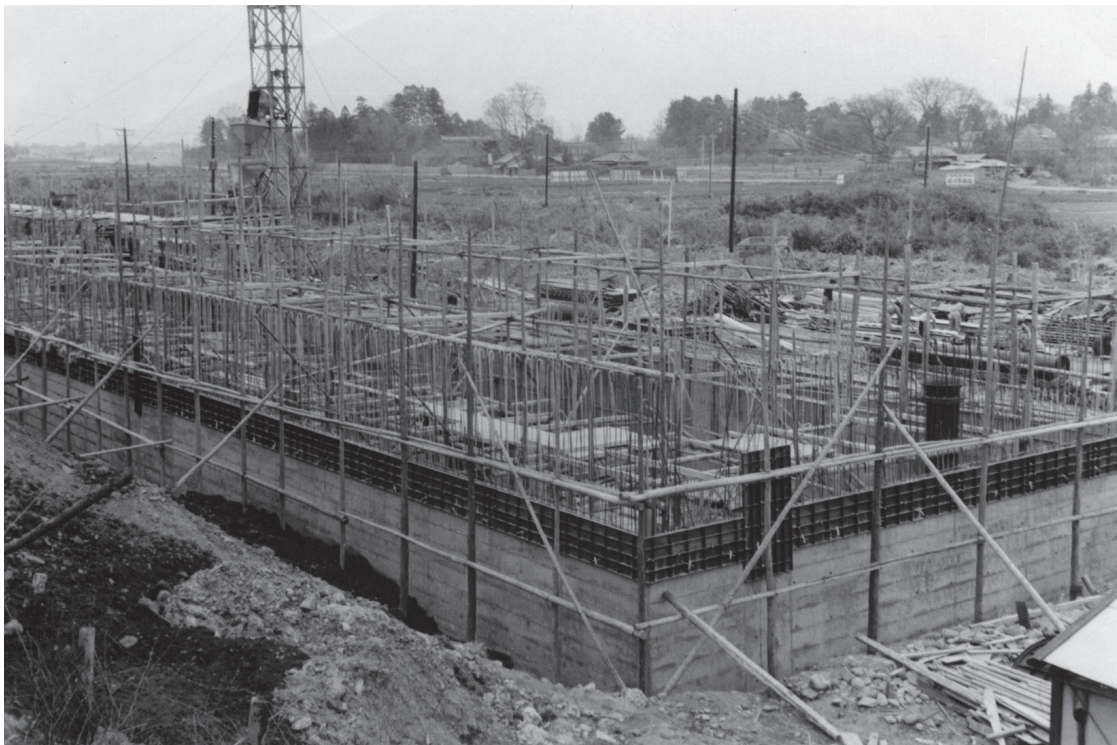
図5-5 築造中の山本浄水場配水池(昭和41年2月)
