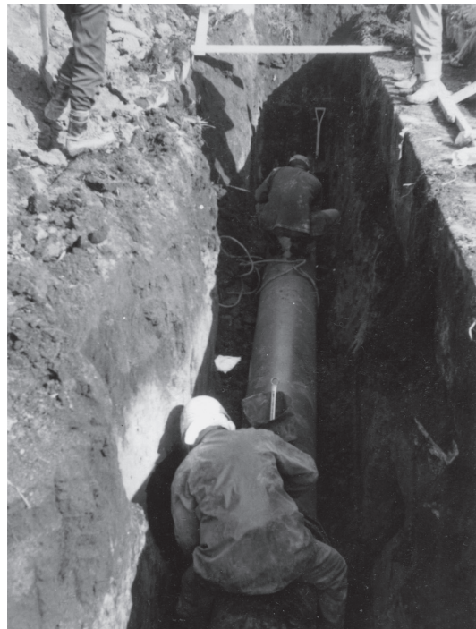
図5-10 県道上阿久津宇都宮線（白沢街道）での配水管布設工事（昭和44年1月）
