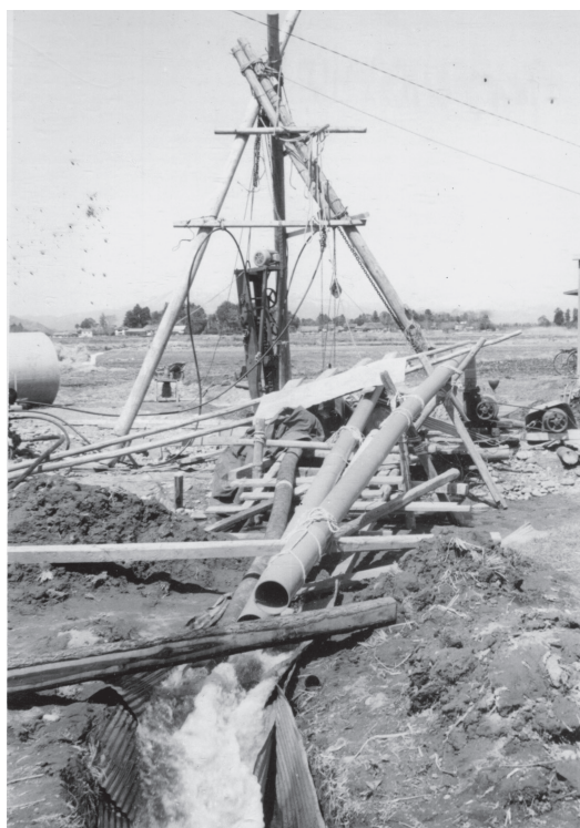
図5-6 水源水質調査による試掘
