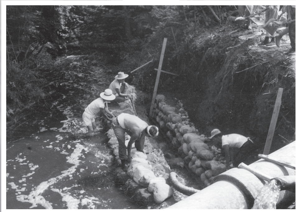
奈坪川水管橋での配水管布設工事
