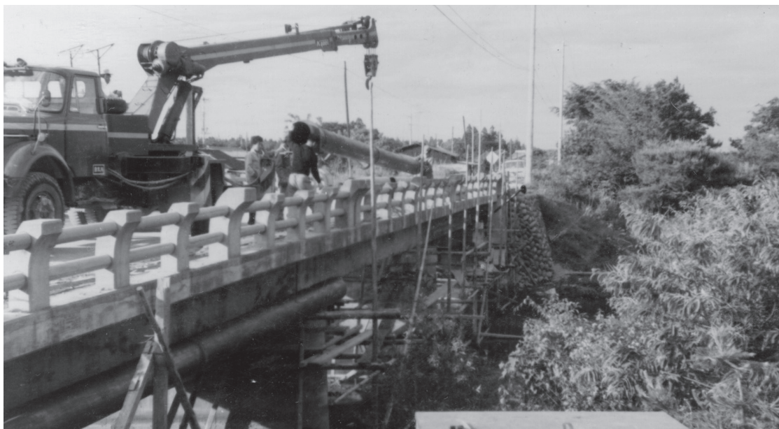
図5-11 県道上阿久津宇都宮線(白沢街道)に架かる橋での配水管布設工事(昭和44年5月)
