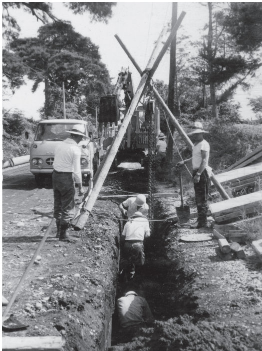
図5-9 県道上阿久津宇都宮線（白沢街道）での配水管布設工事（昭和43年5月）
