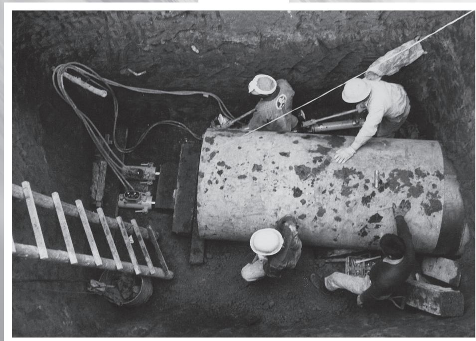
推進工法による下水道工事
