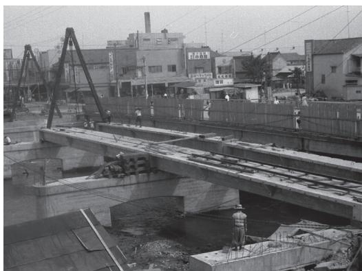
図S3-2 宮の橋架け替え工事(昭和32年8月：宇都宮まちづくり推進機構提供)
