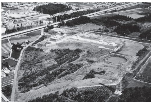
図S5-2 一部供用開始直後の県央浄化センター(上空写真:『流域下水道20年のあゆみ』)
