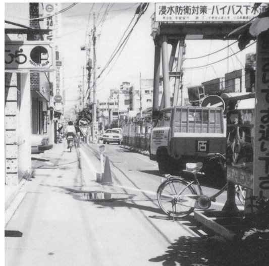
図S5-8 県庁前通りの地下で行われたバイパス下水道工事(昭和58年:『釜川のあゆみ 釜川竣工記念誌』)
