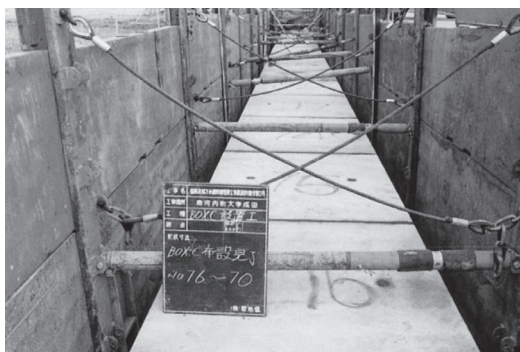
図S5-1 開削工法による放流幹線管渠工事(旧南河内町:『流域下水道20年のあゆみ』)
