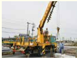
▲現場では安全第一です
