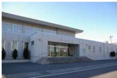
上河内体育館
