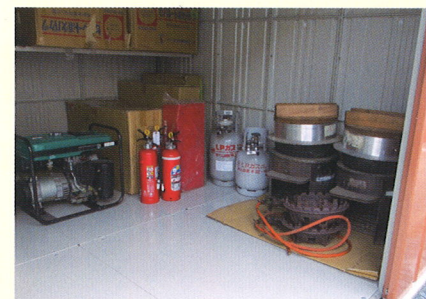
増設防災倉庫内部
