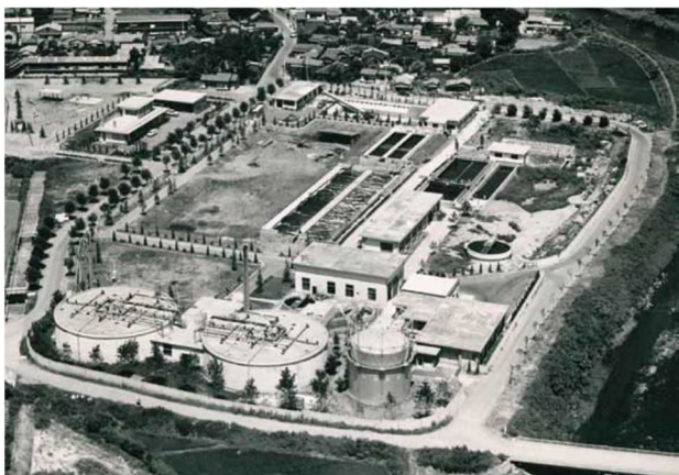
創設当初の下河原下水処理場 (現下河原水再生センター)
