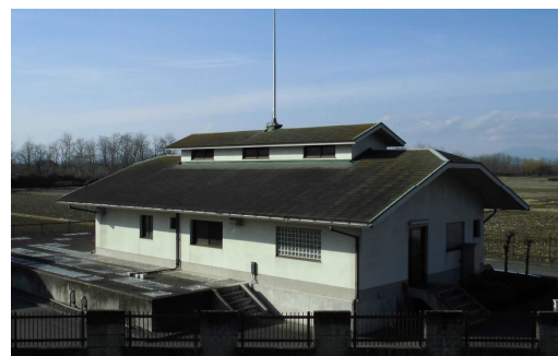
農業集落排水処理施設
