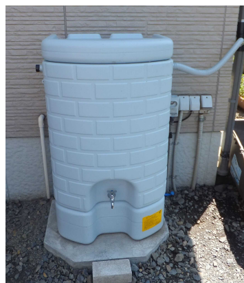
宅地内雨水貯留施設
