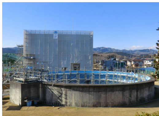
松田新田浄水場の設備更新工事
