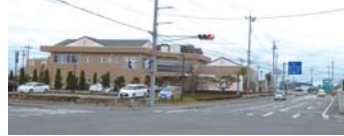
▲平石地区市民センター周辺の様子
