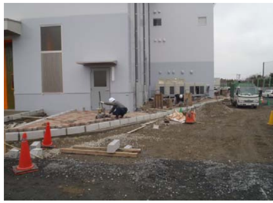
構内道路(北西部)
