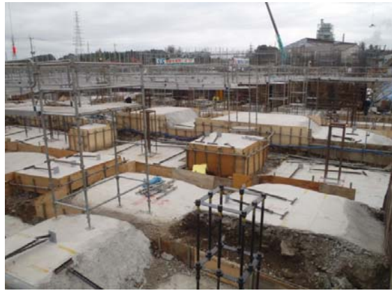
プラットホームエリア基礎(ごみ焼却棟)
