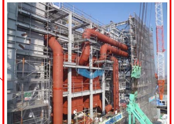
炉室エリア(ごみ焼却棟)
