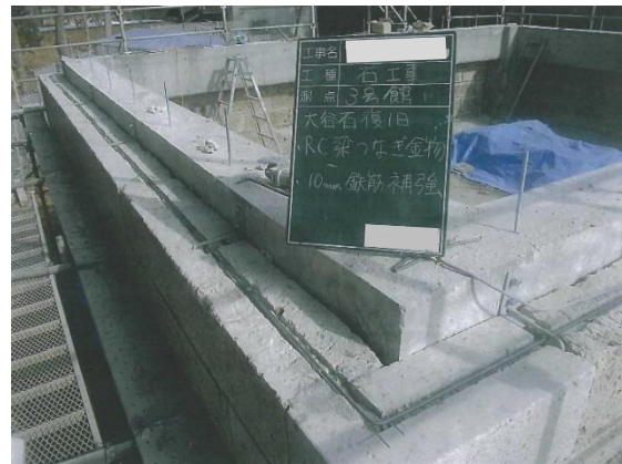
移転先の基礎施工例
