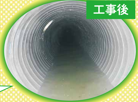
補強工事を行った下水道管
