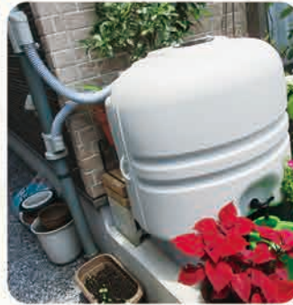
雨水貯留タンク
