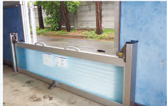
止水板の設置
