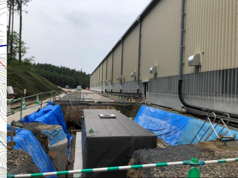
雨水貯留槽工事
