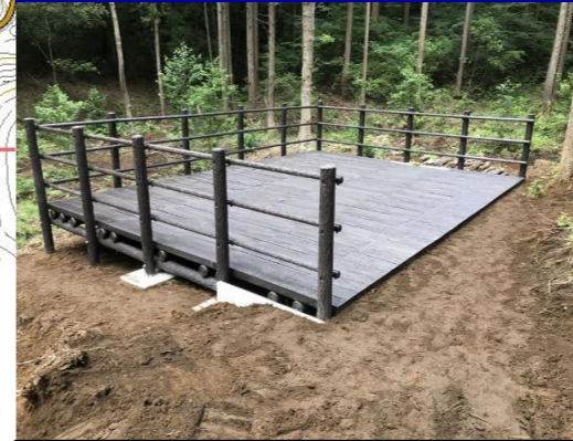
東側湿地工事
