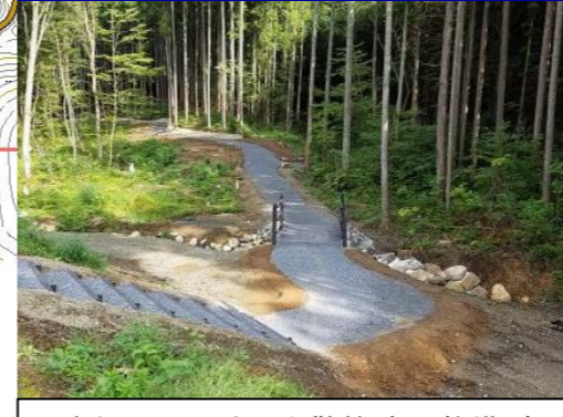
東側湿地工事
