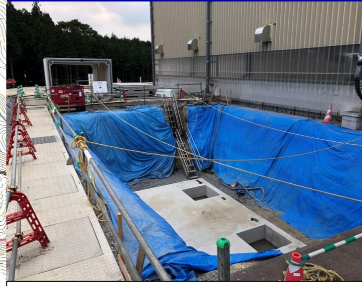
防火水槽工事
