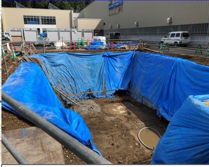
防火水槽工事
