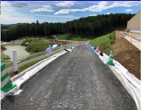
付替通路工事
