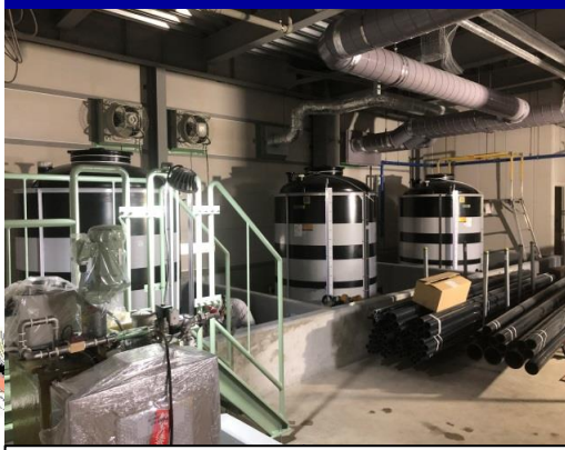
プラント設備工事
