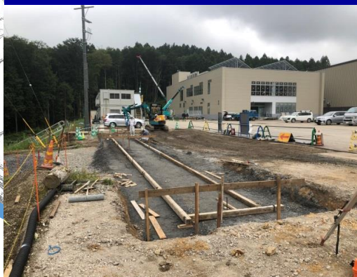
門扉囲障工事
