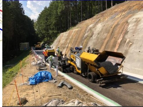
付替通路工事
