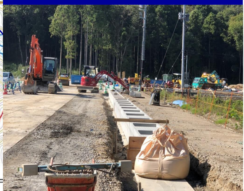
雨水排水工事
