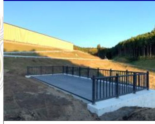
観察テラス工事
