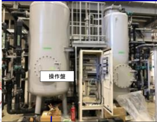
プラント設備工事
