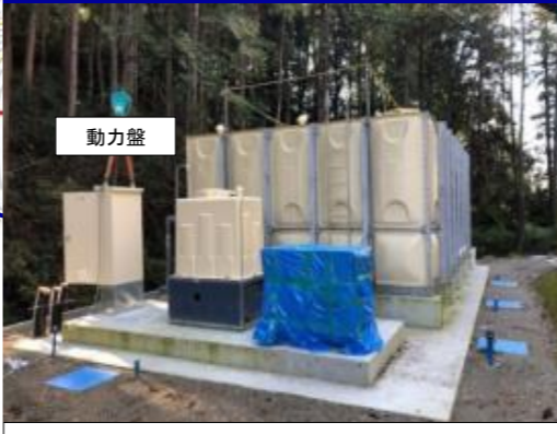
受水槽設備工事
