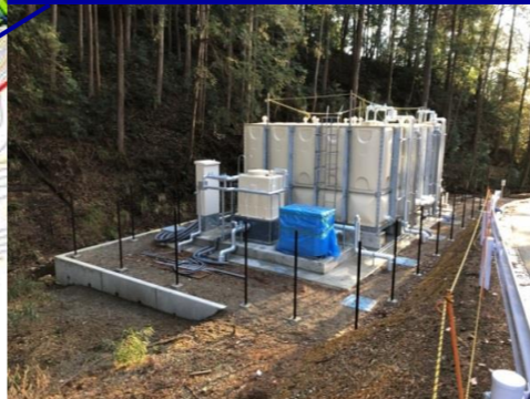
受水槽設備工事
