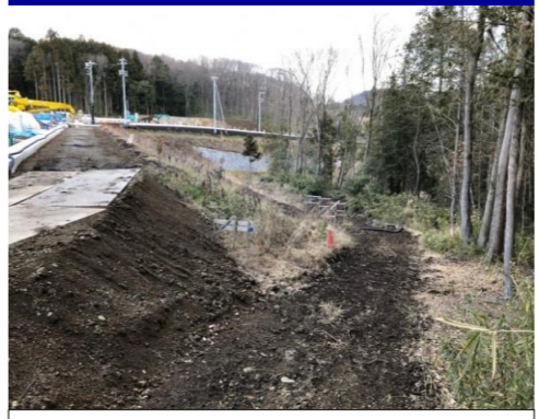
北側沢取水設備工事
