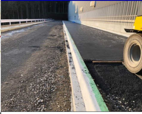
管理道路工事
