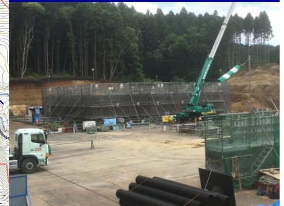
管理棟・浸出水処理施設工事
