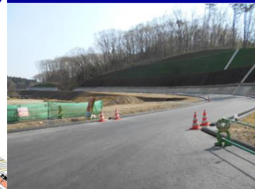
取付道路工事
