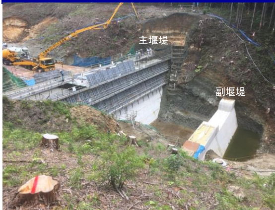
雨水調整池工事
