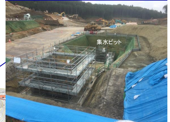
浸出水集水ピット工事
