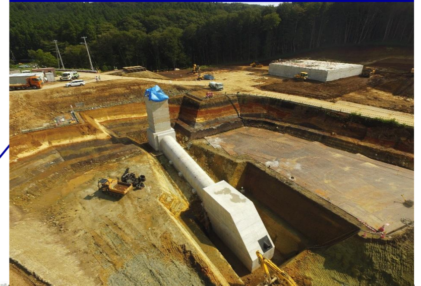
浸出水集水ピット工事
