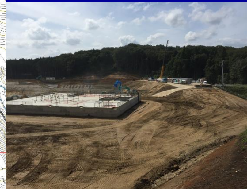
管理棟・浸出水処理施設工事
