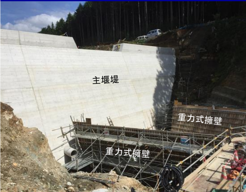
雨水調整池堰堤工事
