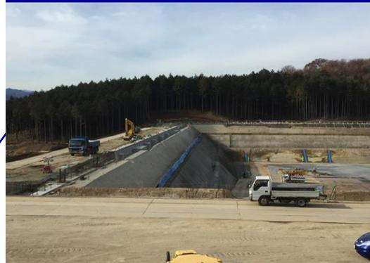
埋立地の造成が完了しました。引き続き、法面モルタル吹付の施工を行っております。
