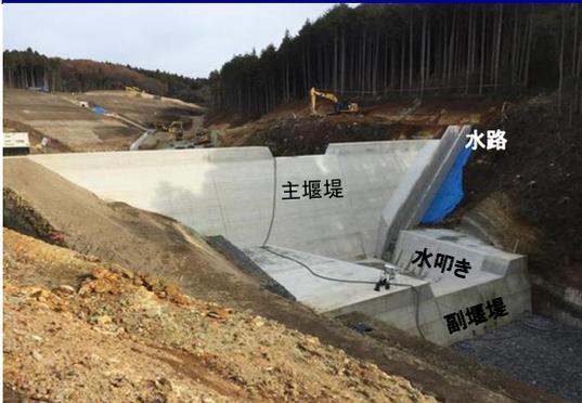
雨水調整池の主堰堤・副堰堤、水叩き、水路が完成しました。
