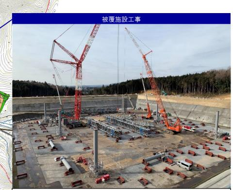
750t・250t吊りの大型クレーンを利用して、被覆施設の鉄骨建方工事 を行っております。
