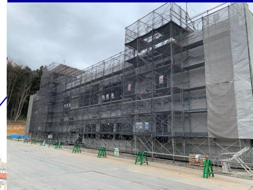
管理棟・浸出水処理施設工事
