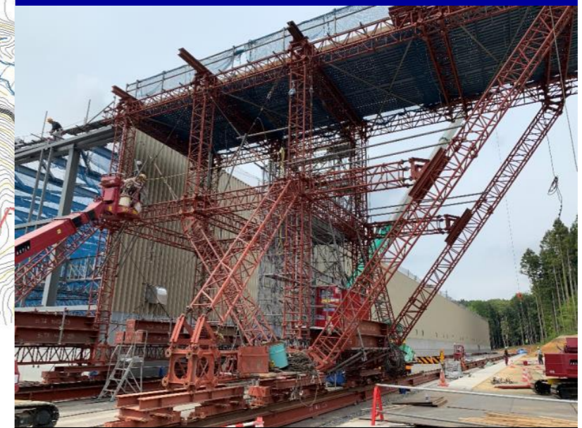
被覆施設屋根工事(移動式ステージ設置)
