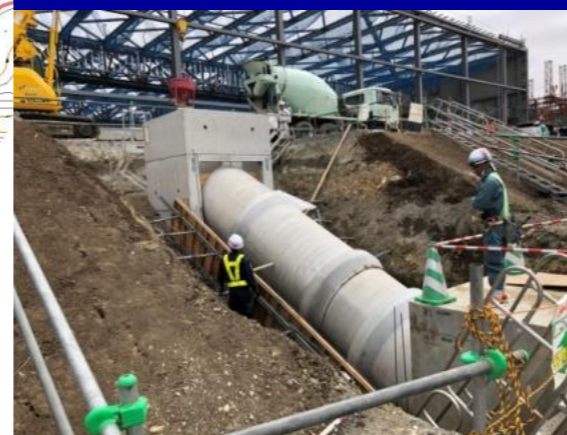
雨水集排水施設工事
