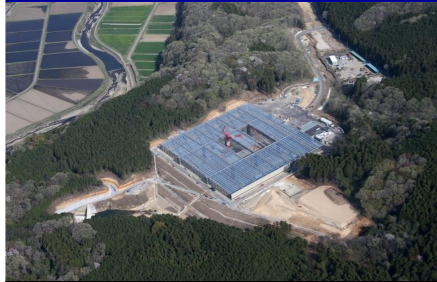
航空写真(全体)
