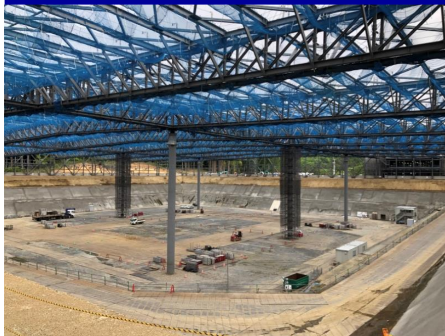
被覆施設工事
