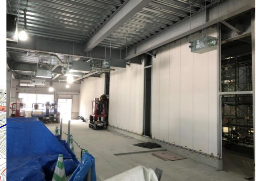
管理棟・浸出水処理施設工事
